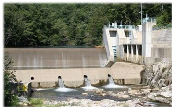
町営小水力発電所
