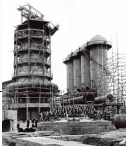
写真：建設中の官営製鐵所第一高炉(1900年) 提供：新日鐵住金株式会社八幡製鐵所
