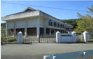
上図：旧袖野木小学校
